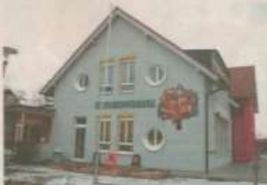
Der Kindergarten der Gemeinde Krenglbach soll durch einen Holzriegelbau erweitert werden.
